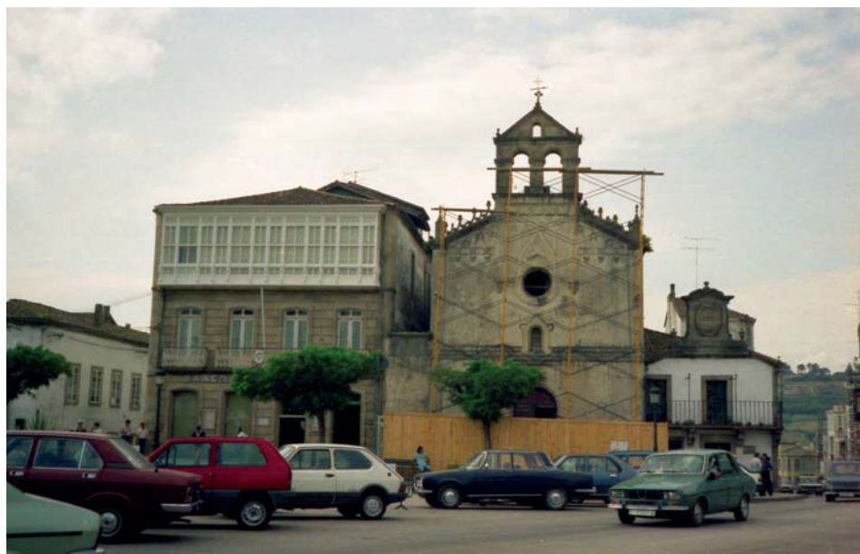
Arriba, imaxe final da capela de San Roque, aínda enteira, o 4-X-1983. Abaixo, inicio do derrubamento do campanario o día 6. Fotos: Alfredo Erias.
