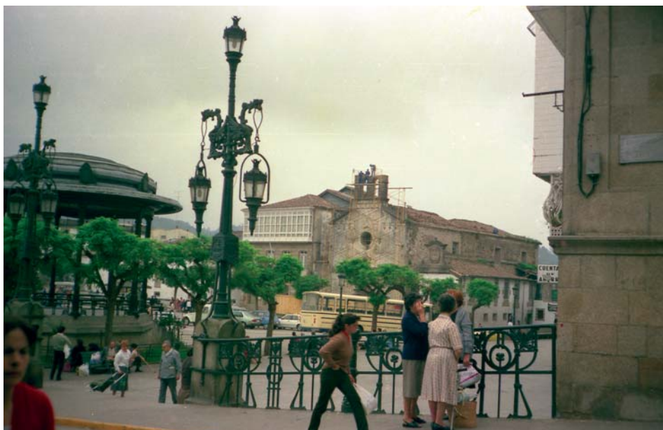
Arriba, inicio do derrubamento do campanario o día 6, visto desde a Porta da Vila. Abaixo, empeza a tirarse a fachada (7-X-1983). Fotos: Alfredo Erias.
